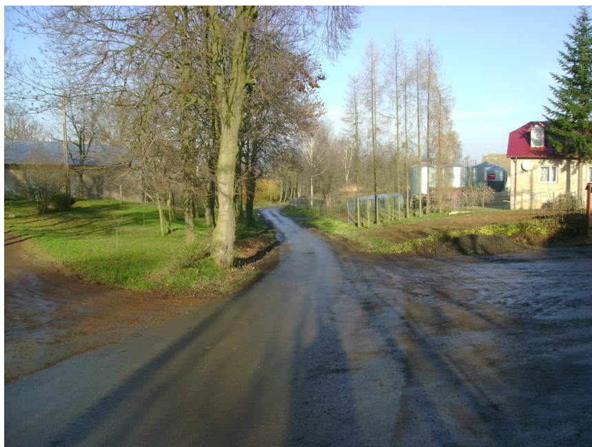
Fotografia Nr 10. Drogi w miejscowości Szczucice – stan obecny.
