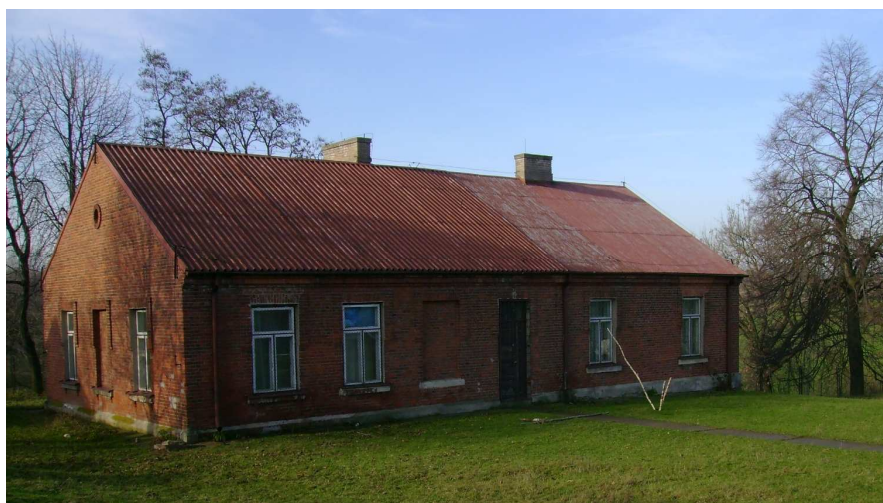
Fotografia Nr 2. Świetlica wiejska w Szczucicach – widok tylnej części budynku.
