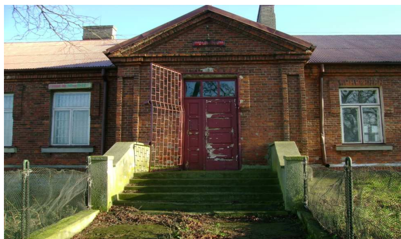
Fotografia Nr 3. Świetlica Wiejska w Szczucicach – widok od frontu.
