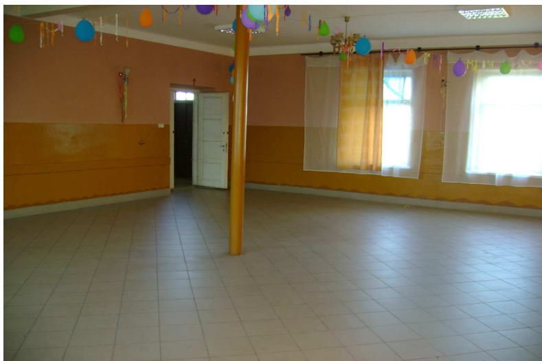
Fotografia Nr 6. Świetlica Wiejska w Szczucicach – wewnątrz (sala).
