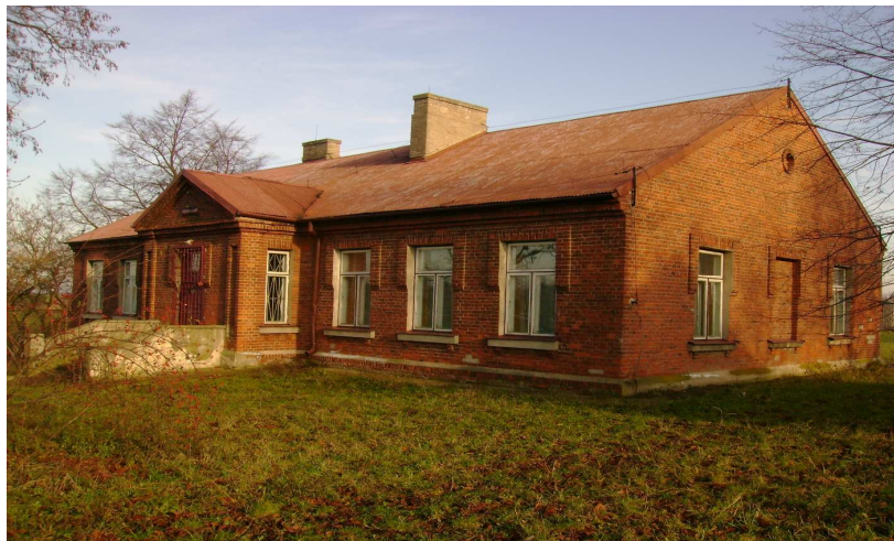
Fotografia Nr 1. Świetlica wiejska w Szczucicach – widok frontowo – boczny.
