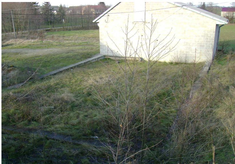
Fotografia Nr 2. Garaż OSP w Łężycach wraz z fundamentami pod budowę nowego obiektu. Fot. Paweł Tracz
