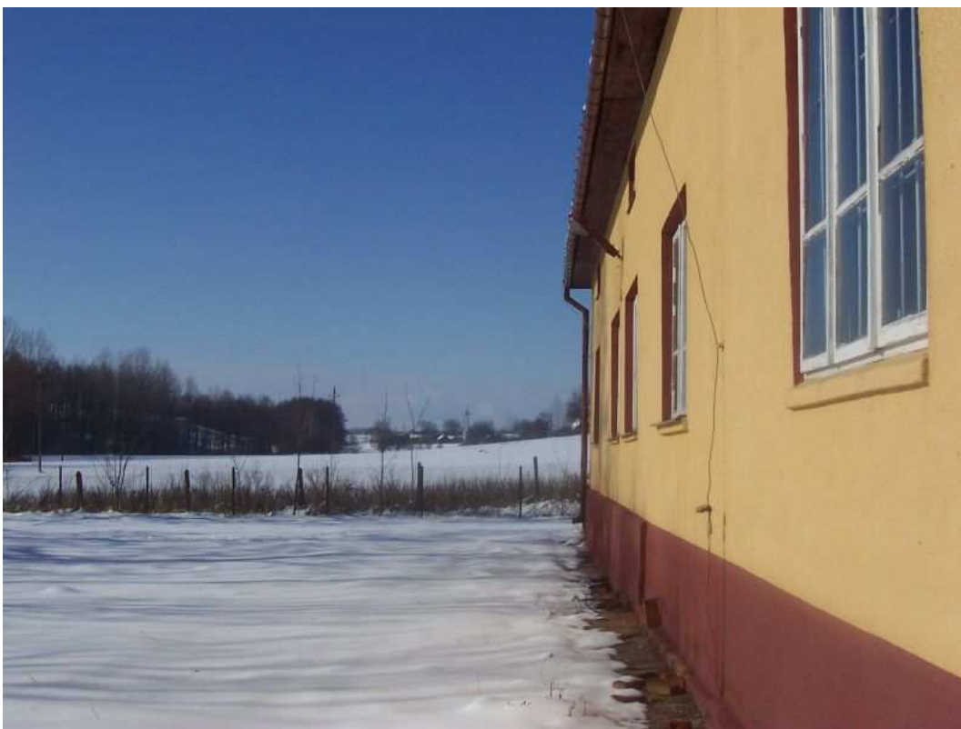
Fotografia Nr 16. Tył budynku Domu Strażaka wraz z terenem przylegającym – stan obecny Fot. Marzena Urban – Żelazowska
