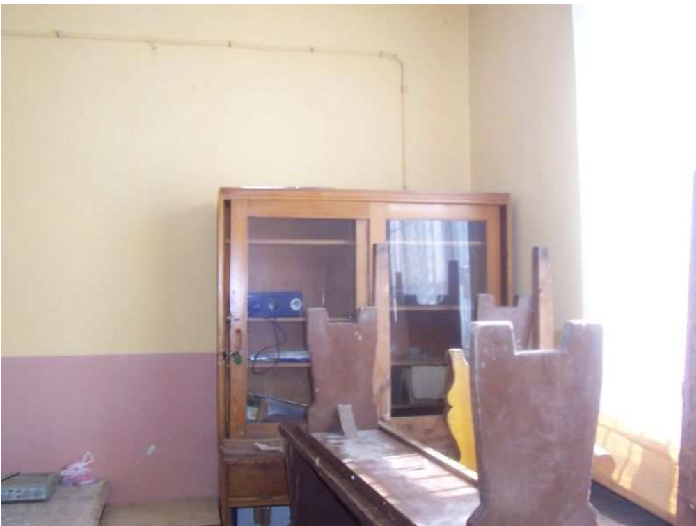
Fotografia Nr 7. Jedno z pomieszczeń Domu Strażaka we Wszechświętych – stan obecny Fot. Marzena Urban – Żelazowska
