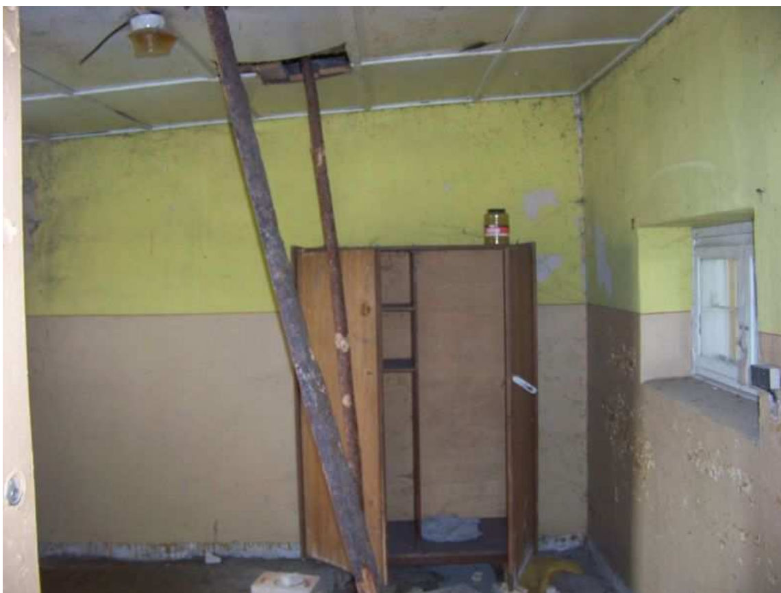
Fot. 11 – Jedno z pomieszczeń świetlicy wiejskiej w miejscowości Rżuchów – stan obecny fot. Piotr Wójtowicz
